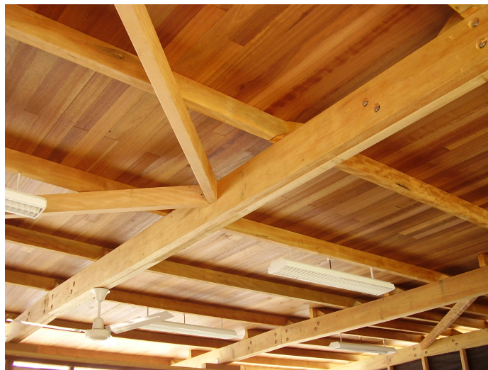
Lycée Gontran Damas : charpente en Mandioqueira et voligeage en Basralocus - Cayenne (Guyane française)
